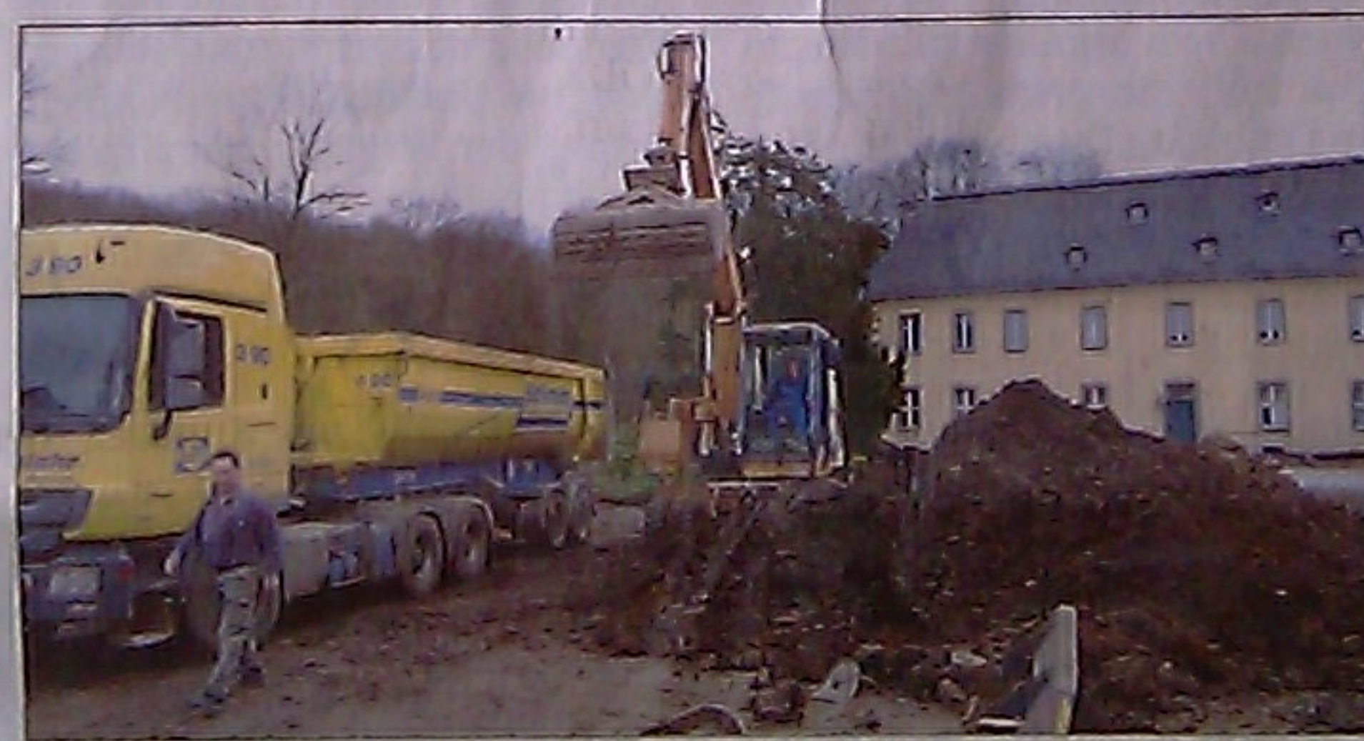
Bagger in Aktion: Der Bereich vor dem ehemaligen Brauhaus wird mit Basaltpflaster neu gestaltet.
